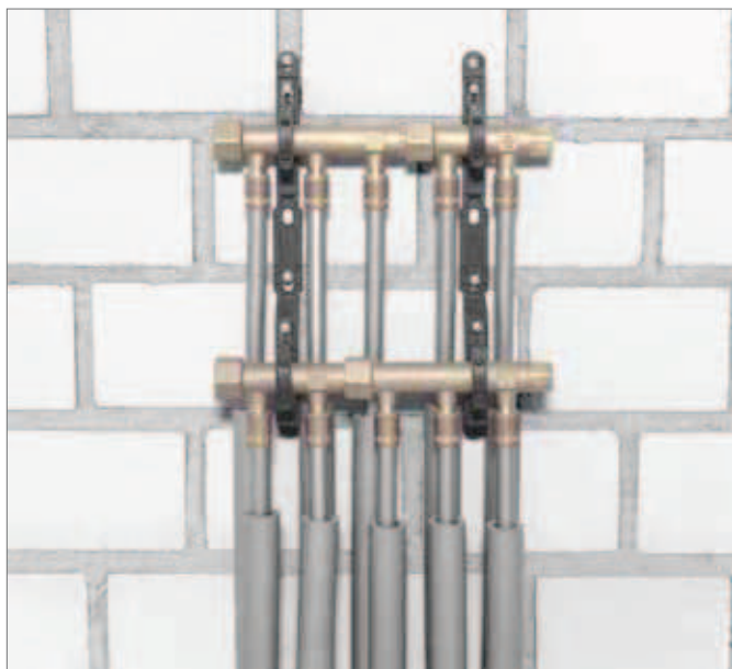
Рис. 19-13 Распределительная гребенка REHAU с присоединением труб с помощью подвижных гильз
